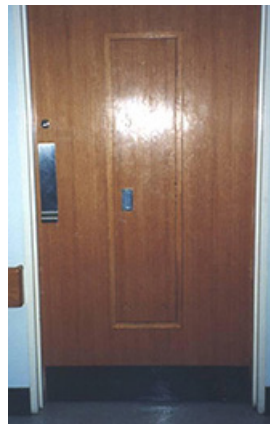
Door, Hallway Side
